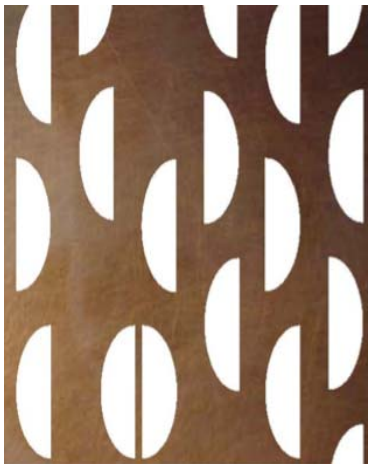
Abb. 10: Raster der Fassade (aus: Bundesministerium der Verteidigung/Planungsstab, Das Ehrenmal der Bundeswehr [Anm. 1], S. 18)
